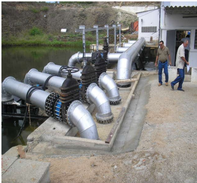
Canal Ererê/Pacoti – Barrilete de recalque das bomba submersas – EB2
