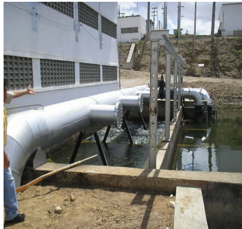
Canal Ererê/Pacoti – Vista do barrilete e flange cego para a implantação da 2ª Etapa – EB2
